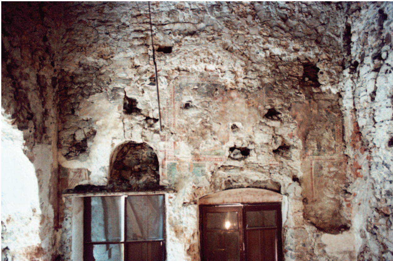
Fig. 6. Lovere, San Martino. Parete sud, prima del restauro (foto Luigi Cottinelli).
