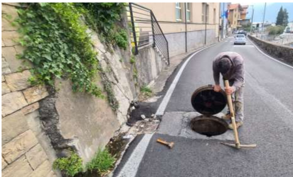
Figura 4.1: ispezione della condotta fognaria presente al di sotto di via Paglia.
