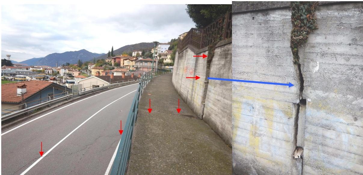
*Fig. 3: Cedimenti dell'asfalto e fessure / rotture nei muri di contenimento lungo la ex S.S. 42 del Tonale*
