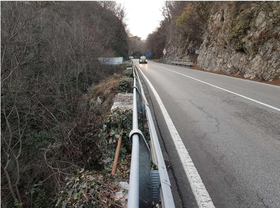
***Percettività 34 – Area della forra fossile – rimozione di tutte le strutture di protezione stradale esistenti, oramai inadeguate - nuove murature di contenimento stradale, ancorate con micropali***
