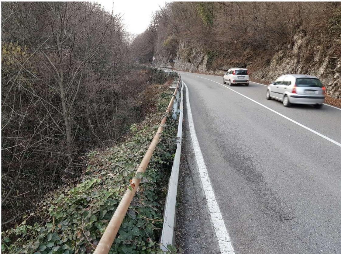
***Percettività 32 – Area della forra fossile – rimozione di tutte le strutture di protezione stradale esistenti, oramai inidonee - nuove murature di contenimento stradale, ancorate con micropali***
