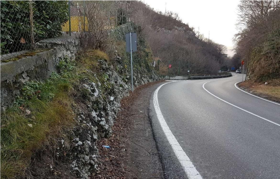
*Percettività 27 – Area di collegamento con via Bergamo – in accordo con la proprietà per consentire il passaggio della pista si prevede la demolizione di parte della roccia fronte strada*
