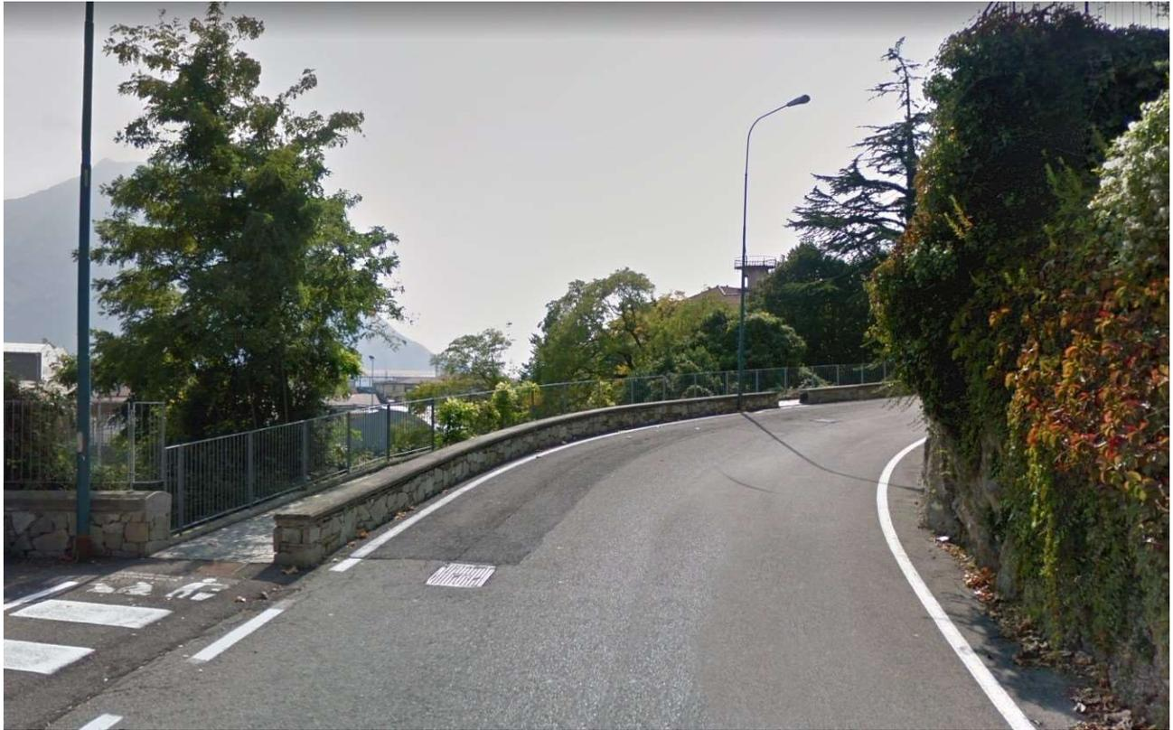
*Percettività 5 – Dopo il parcheggio si mantiene l'attuale percorso pedonale e il muretto; come per il primo tratto la pista si restringe a 2.00 mt – si prevede nuova pavimentazione, cordonature a separazione dal traffico veicolare e la prescritta segnaletica*
