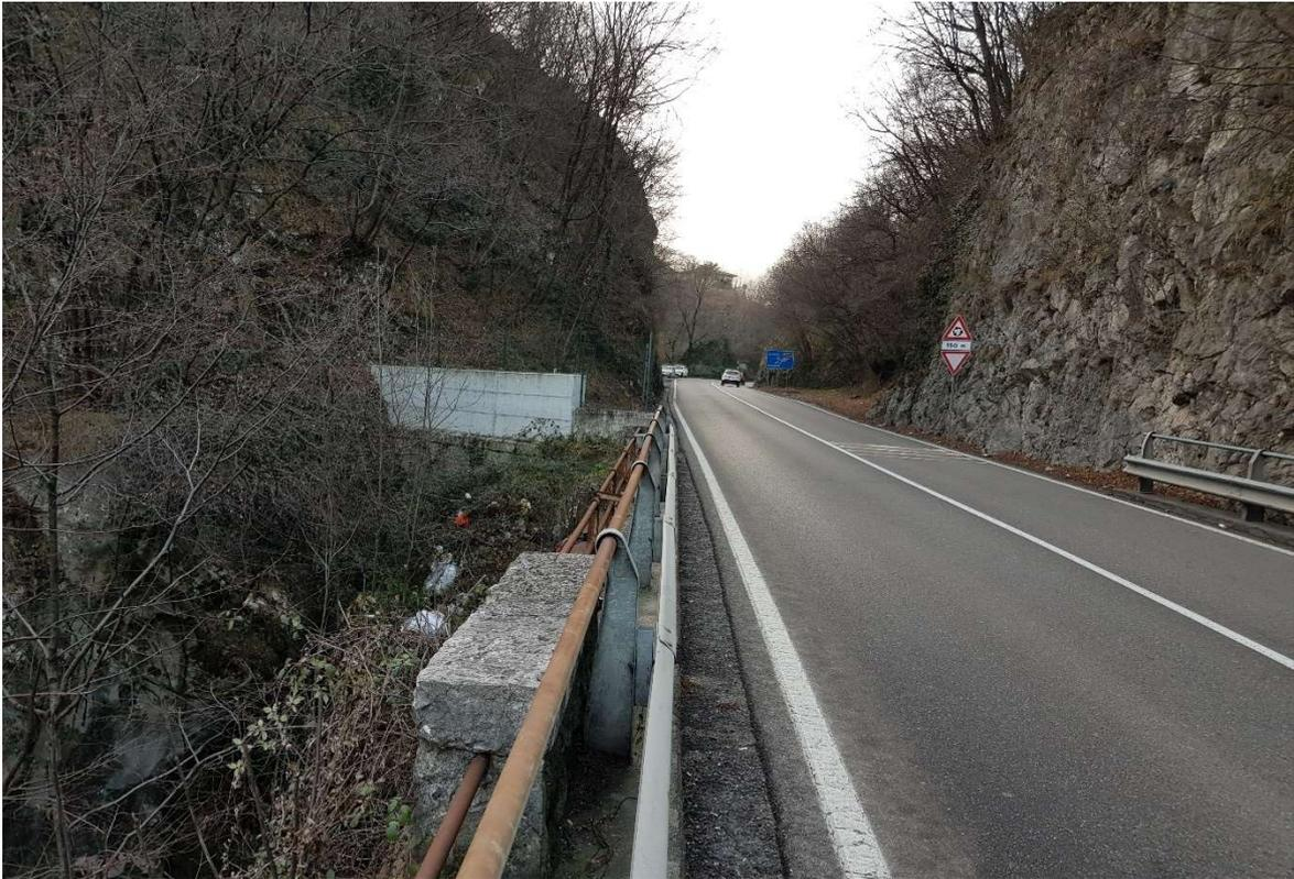
***Percettività 35 – Area del ponte/deviazione – rimozione di tutte le strutture di protezione stradale esistenti, oramai inidonee - nuove murature di contenimento stradale, ancorate con micropali***
