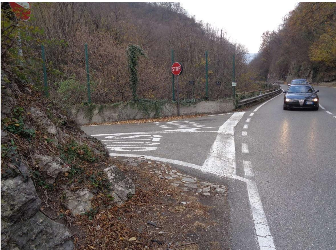
*Percettività 28 – Area di collegamento con via Bergamo – in accordo con la proprietà demolizione di parte della roccia fronte strada e allargamento anche su via Bergamo per facilitare la visuale*
