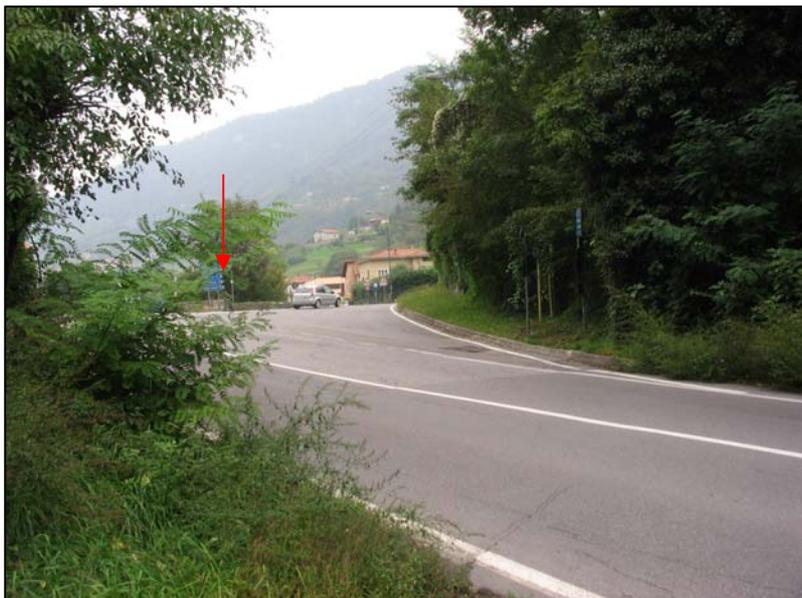
FOTOGRAFIE 10-11: l'incrocio stradale e la ex SS 42 al confine con Castro sono stati realizzati su un viadotto che ha chiuso completamente la forra del torrente Borlezza-Tinazzo (corso d'acqua n° 1); questa è ancora visibile in sito nei punti indicati dalla freccia
