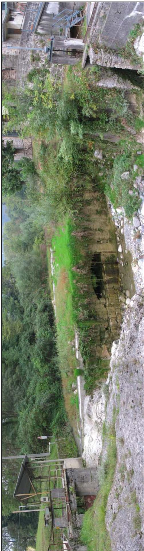
FOTOGRAFIA 7: torrente Borlezza-Tinazzo (corso d'acqua n° 1): sbarramento dell'opera di presa alla quota di 240 m sim circa
