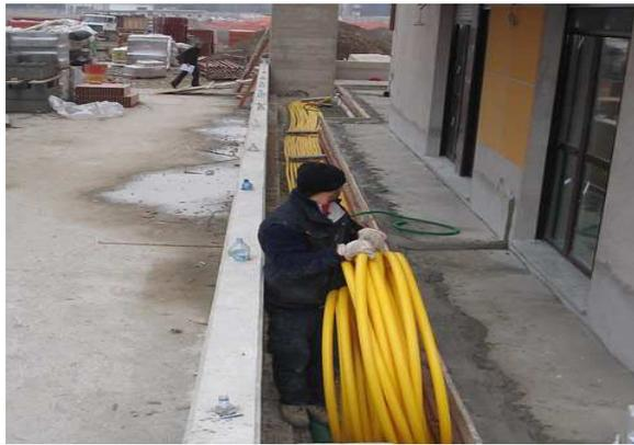
b) in polifora o cavidotto: manufatti costituiti da elementi tubolari continui, affiancati o termosaldati, per insilaggio di più servizi di rete;
